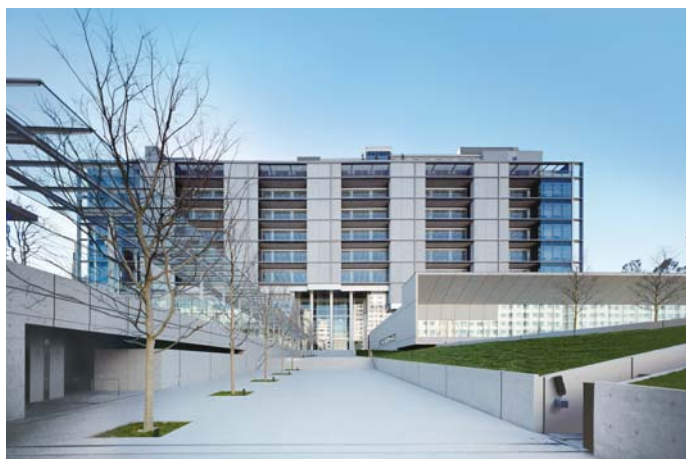
⑨明治安田生命新東陽町ビル 東京都江東区 基本設計・当社：朝田秀樹 施工・佐藤恭輔 岩崎和義 構造階数 S(一部RC)／B1,F12,P1 延床面積 96,911m 2
