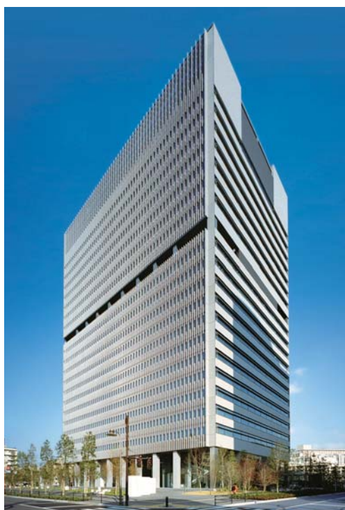
⑥東洋製罐本社ビル 東京都品川区 設計・当社：澁谷 学 施工・黒崎信之 関 和彦 構造階数 RC・SRC/S/B2,F21,P1 延床面積 72,543m 2
