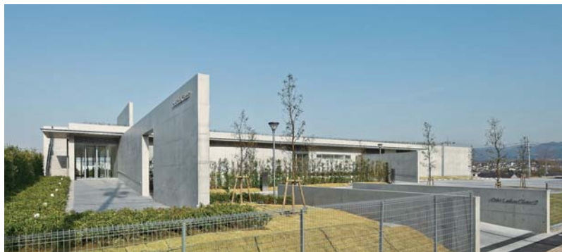
①老木レディスクリニック 大阪府和泉市 設計・安藤忠雄建築研究所 施工・安藤幸一 構造階数 RC/B1,F1 延床面積 1,164m 2
