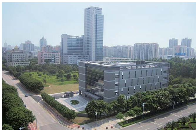
③⑧富士通華南データセンター 中華人民共和国広東省佛山市 設計・迪致工程顧問有限公司 広東南海国際建築設計有限公司 施工・吉原健一郎 構造階数 RC/B1,F4,P1 延床面積 12,222m 2
