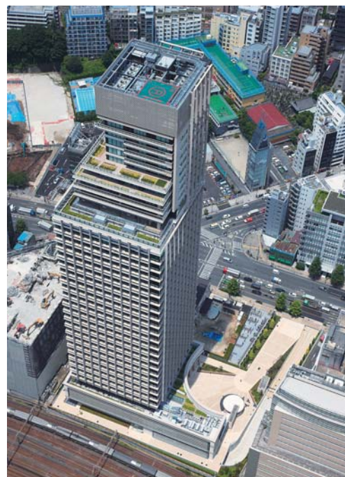
⑦三田ベルジュビル 東京都港区 設計・当社：藤田純也 篠崎 淳 施工・西村和也 中嶋佳男 構造階数 S・RC・SRC/F33,P2 延床面積 55,811m 2
