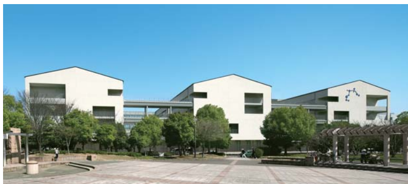
②京産大学施設・附属中高 京都市下京区 設計・当社：梅田善愛 施工・横木恵二 構造階数 RC・一部SRC・S/B1,F4 延床面積 34,949m 2
