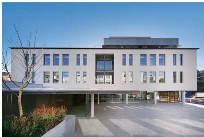
⑭聖母大学第一校舎建替 東京都新宿区 設計・当社：江波戸 宏 施工・武政高弘 構造階数 RC・S/B1,F14,P1 延床面積 5,789m 2
