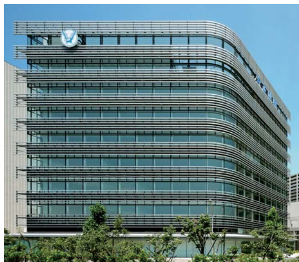
②⑦大正製薬大阪支店 大阪府豊中市 設計・当社：原 哲也 施工・轟木悦朗 構造階数 SRC・S/B2,F8,P1 延床面積 11,967m 2
