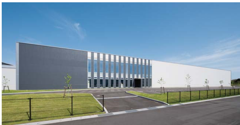
①福井鋸螺細呂木事業所第9棟 福井県あわら市 設計・当社：野村昌宏 施工・関塚良和 構造階数 S/F2 延床面積 6,927m 2
