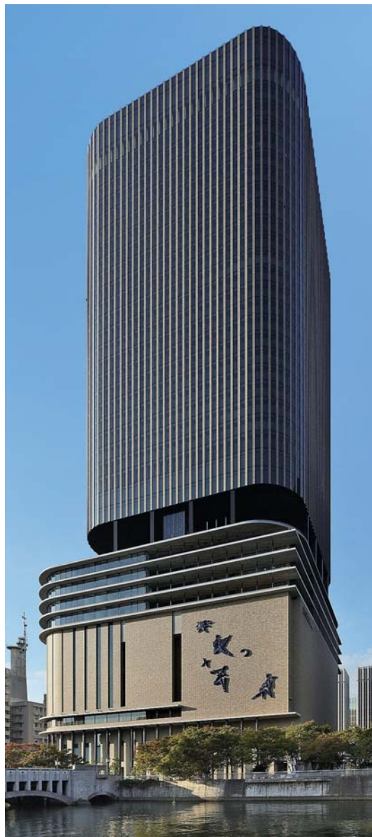
④中之島フェスティバルタワー 大阪市北区 設計・㈱日建設 施工・光枝 良 山本啓介 構造階数 S・SRC・RC/B3,F39 延床面積 148,834m 2
