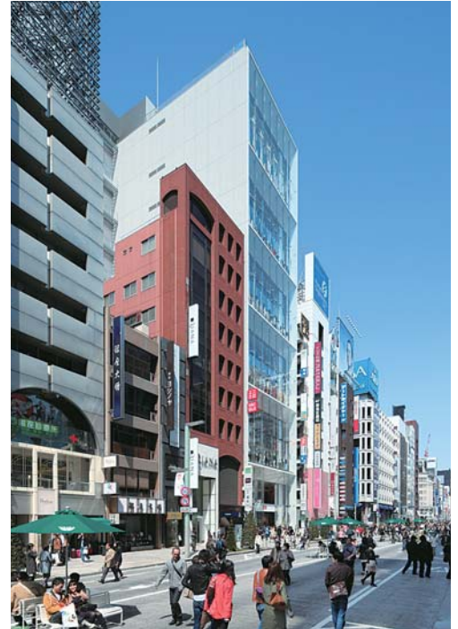
③ギンザコマツビル 東京都中央区 設計・基本計画：みかんぐみ 当社：宮田二郎 施工・金子 眞 構造階数 SRC・S・RC/B2,F12,P2 延床面積 16,564m 2
