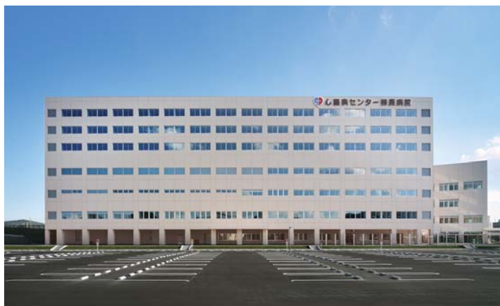
③③心臓病センター榊原病院 岡山市北区 設計・(株)アーキスコープ 当社：石河幸伸 施工・大井一成 構造階数 RC・一部S/F7,P2 延床面積 46,585m 2
