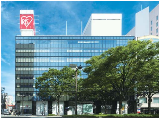
②アイリス青葉ビル改修 仙台市青葉区 設計・当社：木下辰也 施工・宇鉄高史 構造階数 SRC/B2,F9,P4 延床面積 13,275m 2
