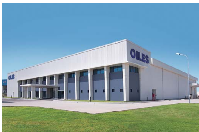
③⑨オイレス工業ニムラナ工場 インド共和国ラジャスタン州 設計・当社：石川憲司 施工・阿部正隆 構造階数 RC,S/F2 延床面積 5,914m 2
