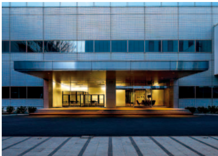
⑥エーザイ筑波研究所東棟免震改修 茨城県つくば市 設計・当社：石川智章 施工・鈴木裕史 構造階数 SRC／B1,F7,P2 延床面積 23,474㎡
