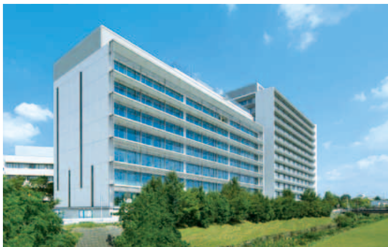
⑮刈谷豊田総合病院新2棟 愛知県刈谷市 設計・当社：市川健二 施工・渡瀬弘久 構造階数 RC／B1,F8,P1他 延床面積 23,481m 2
