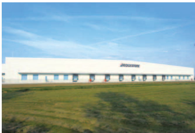
③③ブリヂストンハンガリー工場2期 ハンガリー、クーニャ 設計・CEH zrt. 施工・北折秀規 構造階数 RC・S／B1,F2 延床面積 112,800m 2
