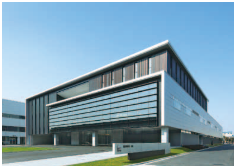
⑤荏原製作所 藤沢事業所 本館 神奈川県藤沢市 設計・当社：高橋一哉 施工・須藤雄二 構造階数 S／F3 延床面積 10,156㎡
