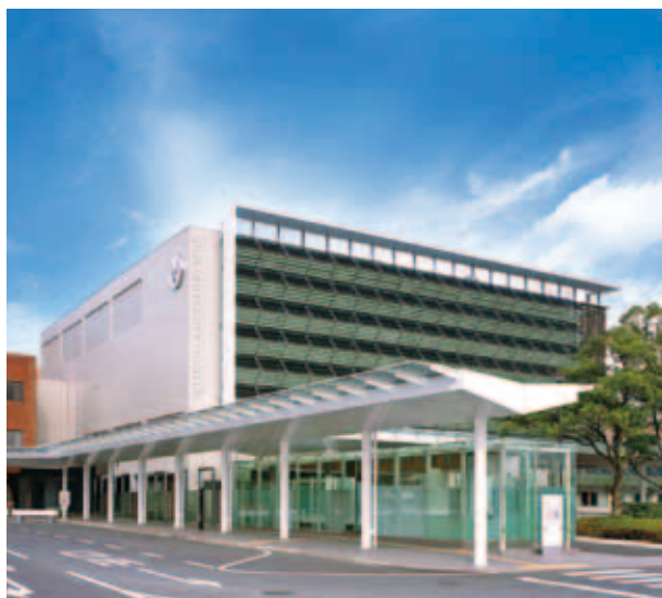
③⑩佐賀大学附属病院診療棟 佐賀県佐賀市 設計・㈱日本設計 施工・有津 均 構造階数 RC/F4,P1 延床面積 6,937m 2
