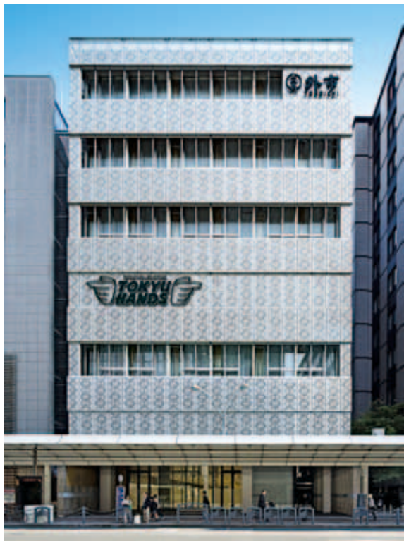
⑪外市京都本社ビル 京都府京都市 設計・当社：森田昌宏 施工・横木恵二 構造階数 S/B2,F7,P1 延床面積 7,866m 2
