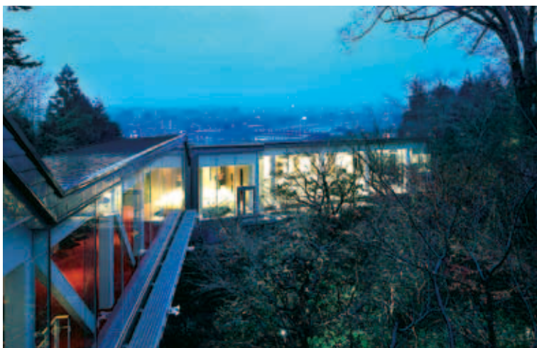
⑯ノバレーゼ金沢辻家庭園増築 石川県金沢市 設計・(株)浦建築研究所 施工・山本高士 構造階数 S・一部RC／B1,F2 延床面積 1,130m 2
