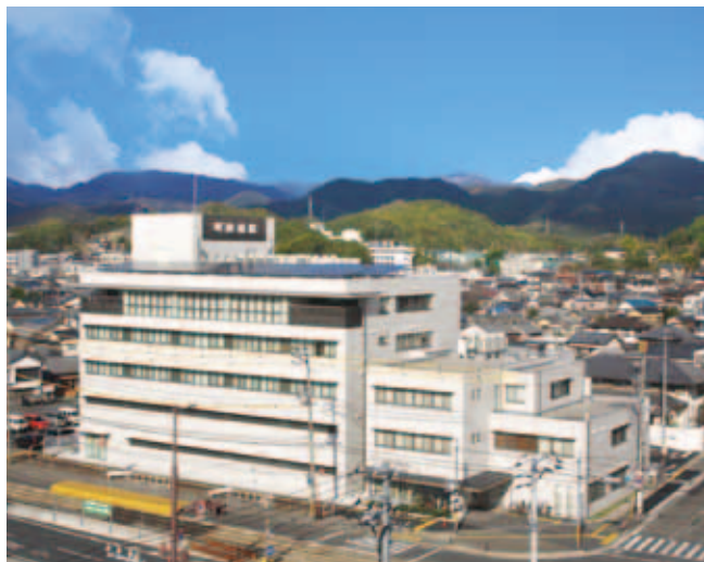
②⑤高知町田病院免震・耐震棟 高知県高知市 設計・(株)センプラン研究所 施工・伊賀上久幸 大井浩司 構造階数 RC/F5 延床面積 4,600m 2
