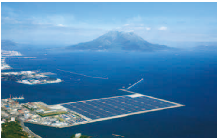
③②鹿児島メガソーラー発電所 鹿児島県鹿児島市 設計・[電気設備]九電工 [基礎・架台・外構]当社 施工・徳久正信 構造階数 その他 延床面積 1,270,000m 2
