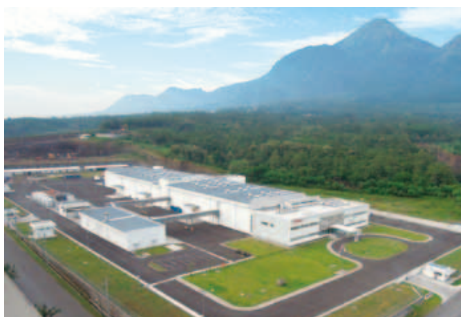
③④ヤクルトスラバヤ（モジョコルト）工場 インドネシア共和国東ジャワ州 設計・当社：小吹達哉 施工・田川彰一 構造階数 RC・S／F2 延床面積 12,641m 2
