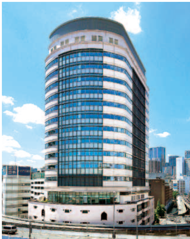
⑦日本橋ダイヤビルディング 東京都中央区 設計・(株)三菱地所設計 当社：加部佳治 施工・市東信明 根本 真 構造階数 S・RC・SRC／B1,F18,P1 延床面積 30,029m 2
