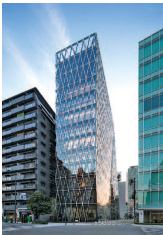
⑰大塚グループ大阪本部大阪ビル 大阪府大阪市 設計・(株)日建設計 施工・緒方政継 構造階数 SRC・一部S／B1,F11,P1 延床面積 7,255m 2
