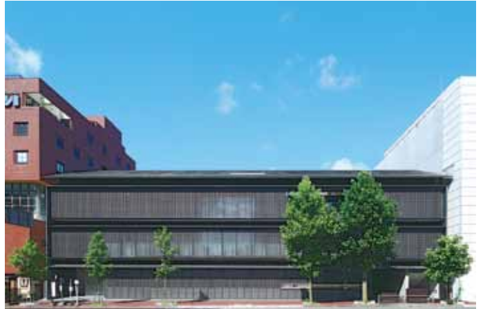
③⑩数研出版新関西本社ビル 京都府京都市 設計・当社：有田 博 施工・山本俊之 構造階数 RC/B2,F4 延床面積 5,553m 2
