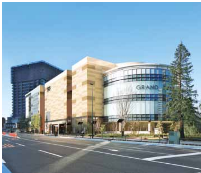
⑬イトーヨーカ堂武蔵小杉SC 神奈川県川崎市 設計・(株)東急設計コンサルタント 施工・井ノ口浩一 中川和彰 構造階数 RC・S/B2,F4,P1 延床面積 108,499m 2
