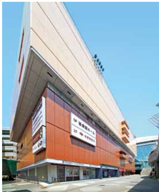
⑦ 東京ドーム青いビル耐震改修 東京都文京区 設計・当社：伊谷 峰 施工・東 浩明 構造階数 SRC・S/B1,F7,P1 延床面積 13,982㎡
