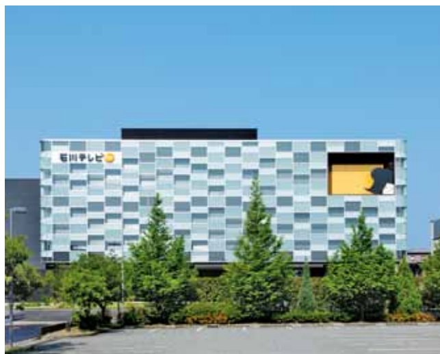
⑮石川テレビ放送メディア館改築 石川県金沢市 設計・日建設計・五井建築研究所設計共同企業体 施工・関塚良和 構造階数 S/F4 延床面積 4,010m 2
