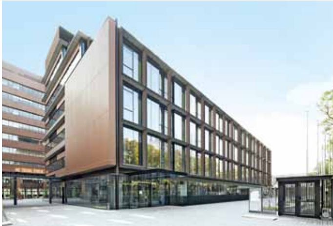
②④大阪国際大学1号館建替 大阪府守口市 設計・(株)安井建築設計事務所 当社：大平滋彦 施工・弦田康平 構造階数 SRC・S/B1,F6,P1 延床面積 10,224m 2
