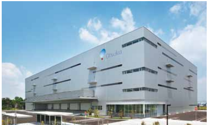
③4 大塚倉庫神戸ロジスティックセンター 兵庫県神戸市 設計・当社：楡山知則 施工・田中克己 構造階数 RC・S/F4 延床面積 31,144m 2
