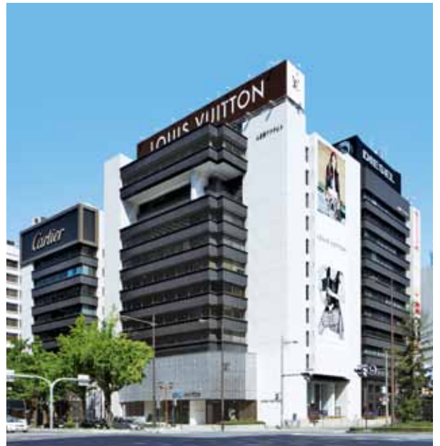
③①心齋橋プラザビル外壁他改修 大阪府大阪市 設計・東西土地建物(株) 当社：小幡剛也 施工・道永 剛 構造階数 SRC/B2,F12,P1 延床面積 26,617m 2
