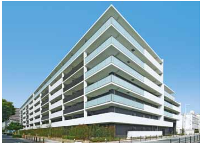
②③ ファインフラッツ関目ザ・レジデンス 大阪府大阪市 設計・当社：菅 孝美 施工・中川英樹 構造階数 RC/F7 延床面積 12,621m 2
