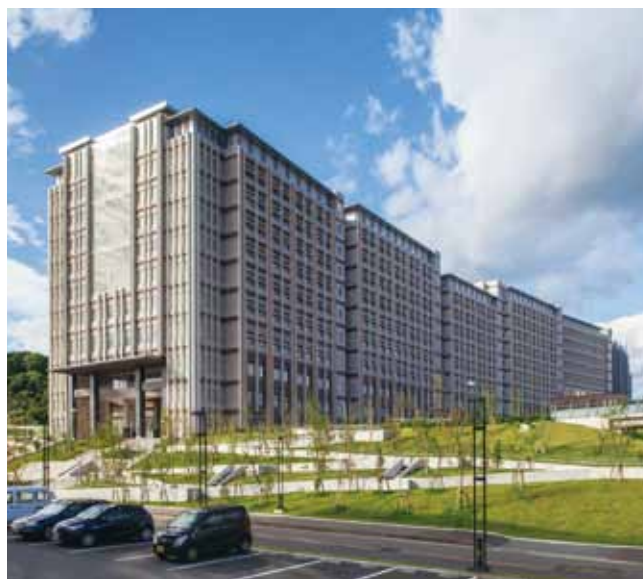
③⑨九大伊都理学系総合研究棟 福岡県福岡市 設計・(国大法)九州大学 当社：森山 悟 施工・三田村英明 構造階数 総合研究棟) S(CFT)/F10,P2 講義棟) RC/F3 民間付帯施設) S/F1 延床面積 54,610m 2
