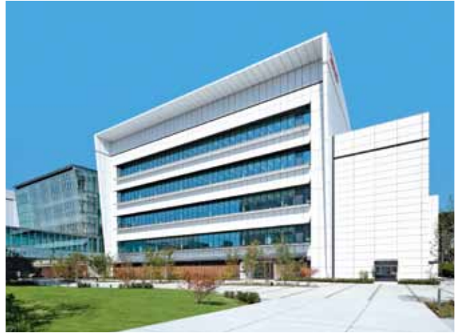
③ヤクルト本社中央研究所基礎研究棟 東京都国立市 設計・当社：横山大造 施工・吉岡 裕 構造階数 S・CFT/F5.P1 延床面積 7,399m 2
