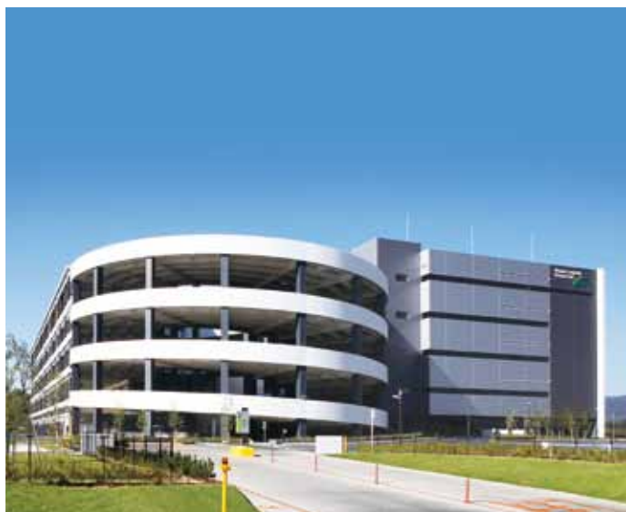
③⑥GLP岡山総社Ⅱプロジェクト 岡山県総社市 設計・「構造」デロイトトーマツPRS(株) 当社：富永隆弘 施工・新村知史 構造階数 RC・SRC・S/F5,P1 延床面積 78,072m 2
