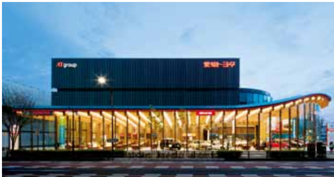
⑰ATグループ本館建替 愛知県名古屋市 設計・当社：長谷川 寛 施工・市川教史 田島俊浩 構造階数 S/F4 延床面積 4,321m 2
