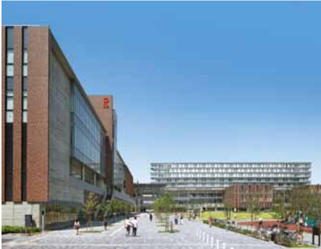
②⑧立命館大学大阪いばらきキャンパス 大阪府茨木市 設計監理統括、基本設計：(株)山下設計 当社：永井 務 河崎敦子 施工：江藤 泉 二見宏次 構造階数 S・RC/F9,P1 延床面積 110,202m 2
