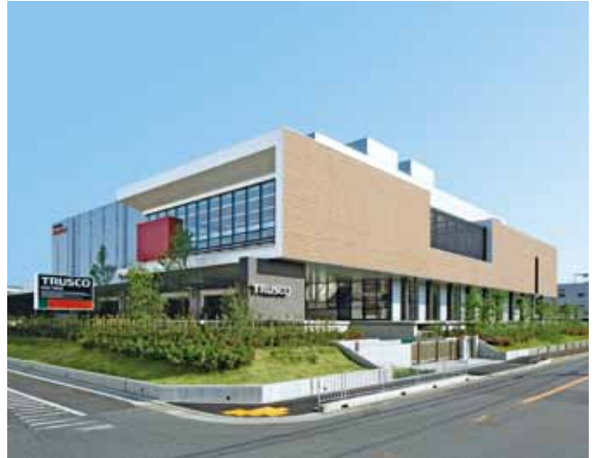
②⑥トラスコ中山プラネット大阪 大阪府堺市 設計・(株)安井建築設計事務所 当社：檜山知則 施工・美濃志武 構造階数 RC・S/F2 延床面積 20,306m 2
