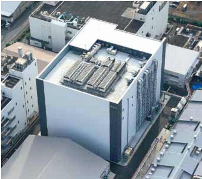
⑨ニコン相模原837号館新棟 神奈川県相模原市 設計・当社：高橋一哉 施工・須藤雄二 構造階数 S/F7 延床面積 10,864m 2
