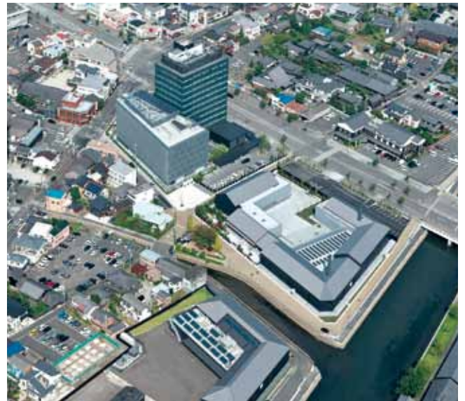
⑲ミツカングループ本社地区再整備 愛知県半田市 設計・(株)NTTファシリティーズ (株)石本建築事務所 施工・石川昭典 構造階数 本社) S・RC免震/B2,F12,P2 研究棟) S・免震/F6,P1 新企業) S・RC免震/F2 延床面積 21,424m 2
