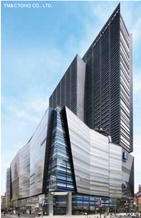
②新宿東宝ビル 東京都新宿区 設計・当社：落合藤雄 宮下信顕 施工・浜島英一 構造階数 SRC・S/B1.F30.P2 延床面積 54,735m 2
