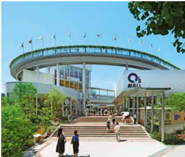
③2 もりのみやキューズモールBASE 大阪府大阪市 設計・当社：原田哲夫 施工・穂山和生 古川英樹 構造階数 S・SRC/F3 延床面積 24,676m 2
