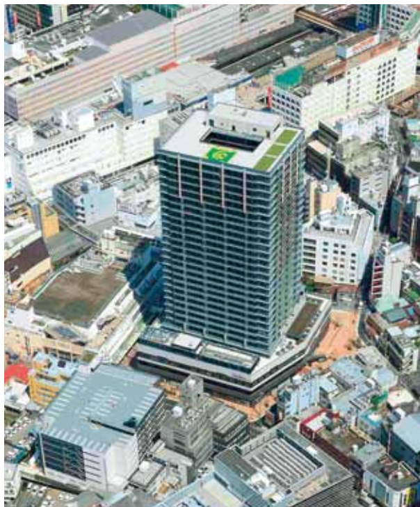
⑦柏駅東口D街区第一地区第一種市街地再開発事業 千葉県柏市 設計・当社：池田 達 施工・辻石慎治 構造階数 RC・S／B1,F27,P1 延床面積 44,086m 2
