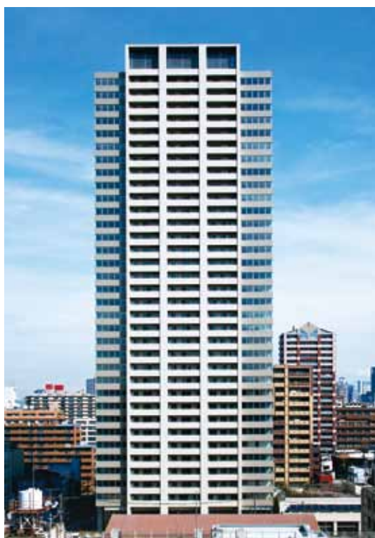
②⑦阪急不動産南堀江住宅建替 大阪府大阪市 設計・当社：合田 靖 施工・海邊 輝 構造階数 RC／F35,P2 延床面積 24,855m 2
