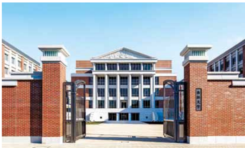
⑫杏林大学井の頭キャンパス 東京都三鷹市 設計・(株)松田平田設計 施工・大内 裕 構造階数 SRC・RC・S/F5,P1 延床面積 45,855m 2
