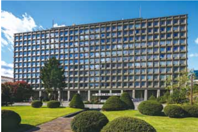
①北海道庁本庁舎耐震改修 北海道札幌市 設計・(株)ドーコン 当社：本井和彦 施工・三浦裕悦 鹿野 譲 構造階数 RC・SRC/B2,F12,P3 延床面積 57,563m 2
