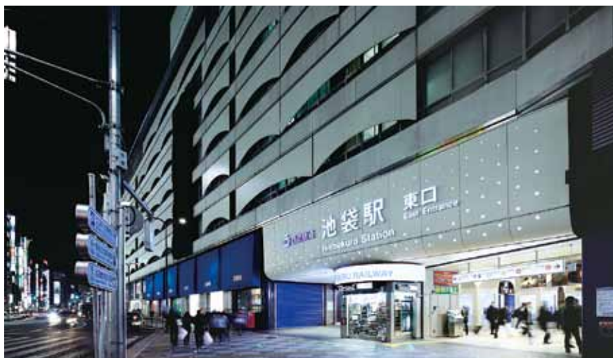
⑮西武鉄道 池袋駅リニューアル 東京都豊島区 設計・西武鉄道・竹中設計JV 当社：高木利彰、橋 保宏 施工・佐久間弘充 構造階数 SRC・その他／西武池袋本店B3,F12,P3、西武池袋駅B1,F2 延床面積 195,123m 2
