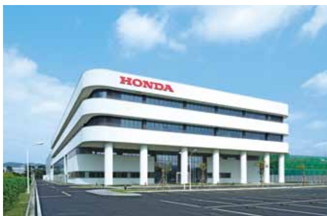
③⑧ホンダ広州新研究センター 中華人民共和国 設計・中国竹中 施工・中国竹中 構造階数 RC/F5 延床面積 47,794m 2
