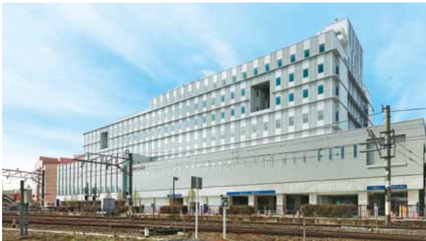
②石巻市立病院 宮城県石巻市 設計・(株)久米設計 施工・岡澤良三郎 構造階数 S/F7 延床面積 23,921m 2
