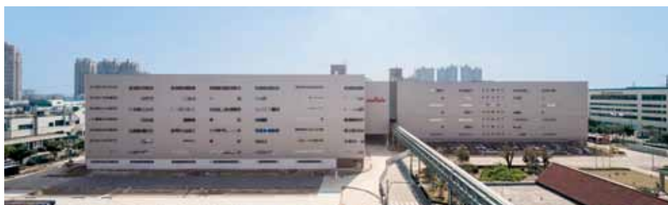
④⑩村田製作所無錫工場E2棟 中華人民共和国 設計・中国竹中 施工・中国竹中 構造階数 RC/B1,F4,P2 延床面積 48,680m 2
