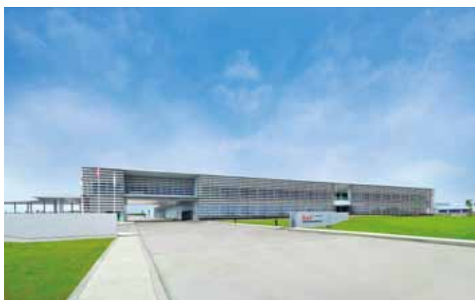
④②大和化成 タイ第2工場 タイ王国 基本デザイン・監修：(株)エムアーキ 実施設計・施工：タイ竹中 構造階数 RC・S/F2 延床面積 46,678m 2
