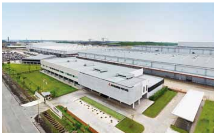
③⑦三菱自動車インドネシア新工場 インドネシア共和国 設計・インドネシア竹中 施工・インドネシア竹中 構造階数 RC・S・SRC/F4 延床面積 177,981m 2
