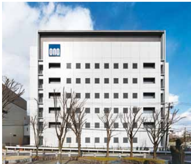
④小野薬品水無瀬新研究棟増 大阪府三島郡 設計・株安井建築設計事務所 施工・中尾和昭、大槻由君 構造階数 RC・S・プレストレスト/F6,P1 延床面積 15,256m 2
