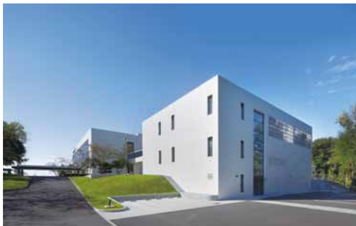
⑤日本臓器製薬株式会社小野緑園工場新動力棟 兵庫県小野市 設計・当社：倉田悦男 施工・中原卓郎 構造階数 RC・S/B1,F2 延床面積 1,359m 2
