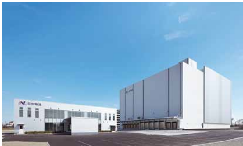
②⑥日水物流大阪舞洲物流センター 大阪府大阪市 設計・共同：ニッスイ・エンジニアリング(株) 施工・美濃武志 構造階数 RC・S／F6,P1 延床面積 19,096m 2
