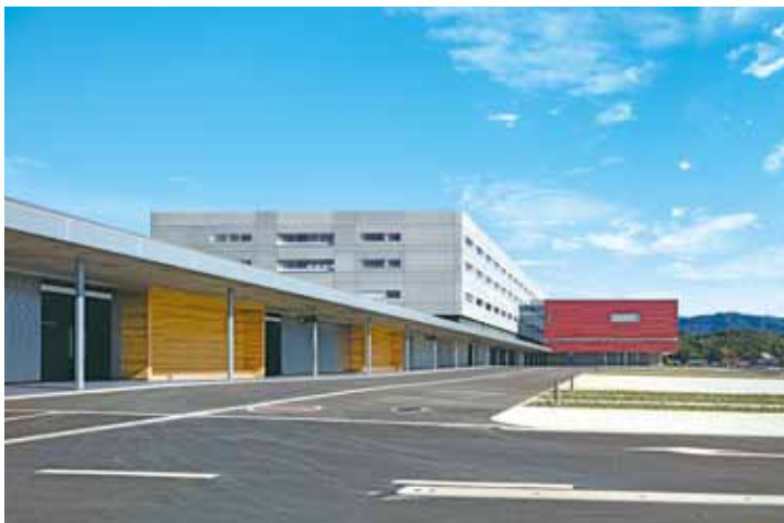
⑩立川綜合病院長岡本院移転 新潟県長岡市 設計・竹中・長建・ワシツ設計JV 当社：菅原 努 施工・堀内雄三 構造階数 RC・S／F6,P1 延床面積 37,796m 2
