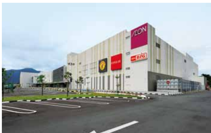
④③イオンビッグイポーSC マレーシア 設計・マレーシア竹中 施工・マレーシア竹中 構造階数 RC/F3,P1 延床面積 90,780m 2
