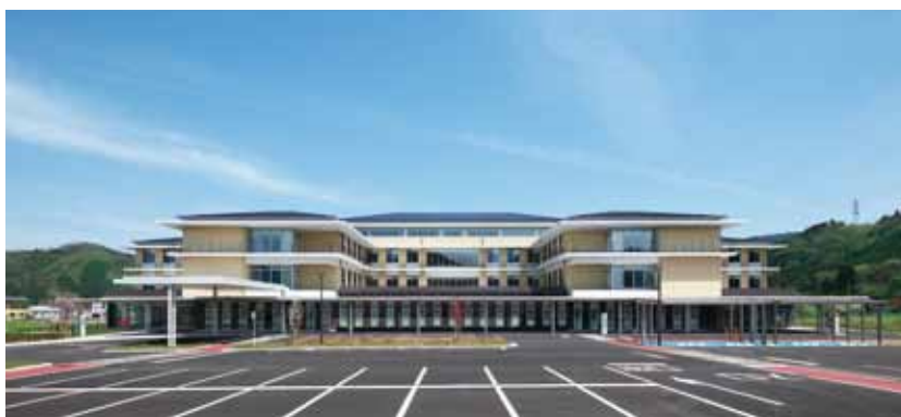
③⑪公立豊岡病院朝来医療センター 兵庫県朝来市 設計・当社：石河幸伸 (株)内藤建築事務所 施工・井上雅史 構造階数 RC/F4 延床面積 13,833m 2
