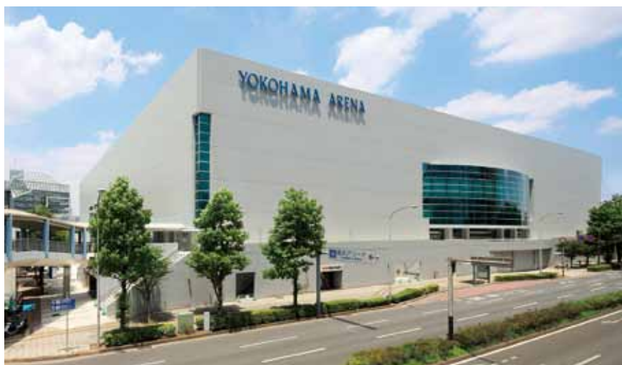
⑯横浜アリーナ大規模改修 神奈川県横浜市 設計・当社：伊谷 峰 施工・松尾弘継 構造階数 SRC／F5,P1 延床面積 45,800m 2
