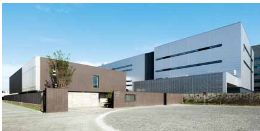
⑥造幣局さいたま支局 埼玉県さいたま市 設計・当社：大日方淳夫 施工・加藤拓郎 構造階数 SRC・RC・S／F7 延床面積 19,379m 2
